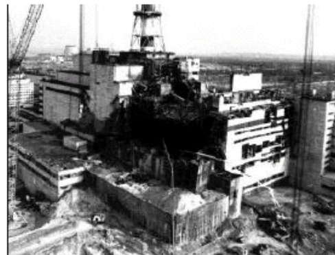
Fig.55 - Il reattore numero quattro subito dopo lo scoppio: la copertura della centrale risulta visibilmente danneggiata
